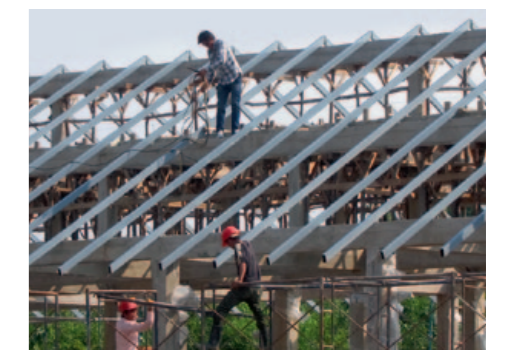
Ein Krankenhaus wird gebaut – nachdem auf dem Gelände drei Granaten geräumt wurden.
