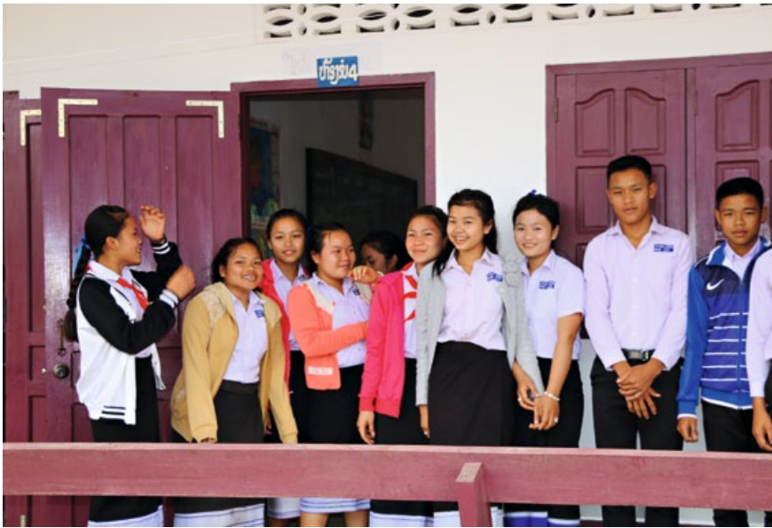
Danger éloigné: pour construire le nouveau bâtiment scolaire de Khok, il a fallu éliminer du terrain les armes à sous-munitions qui s’y trouvaient.
